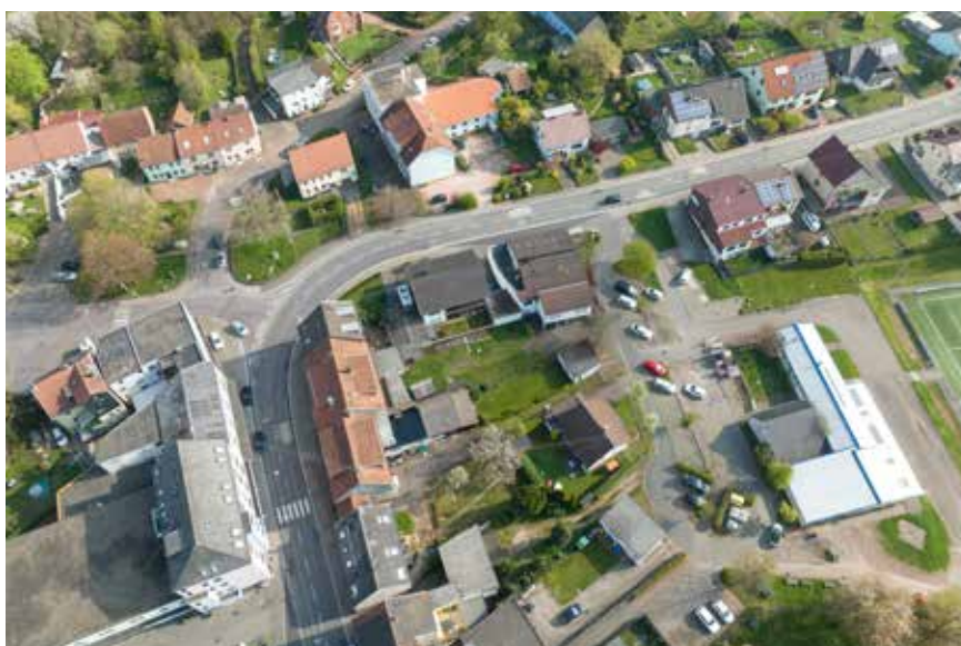
Hauptverkehrsstraße in der Ortsmitte
