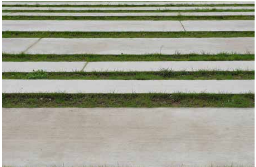
Gestaltung Bodenbelag (Beispielfoto)
