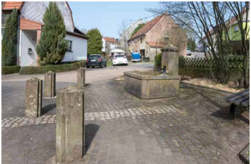
Platzfläche im Kreuzungsbereich Karlstraße/ Grünweg mit Aufwertungsbedarf
