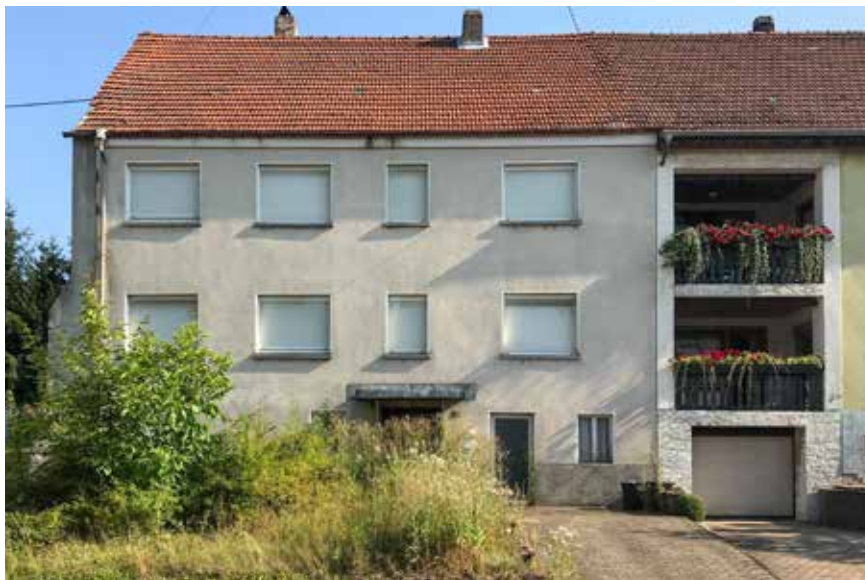
Wohngebäude-Leerstand im Bereich der Ortsdurchfahrt „Welschbachstraße“ (L 141)
