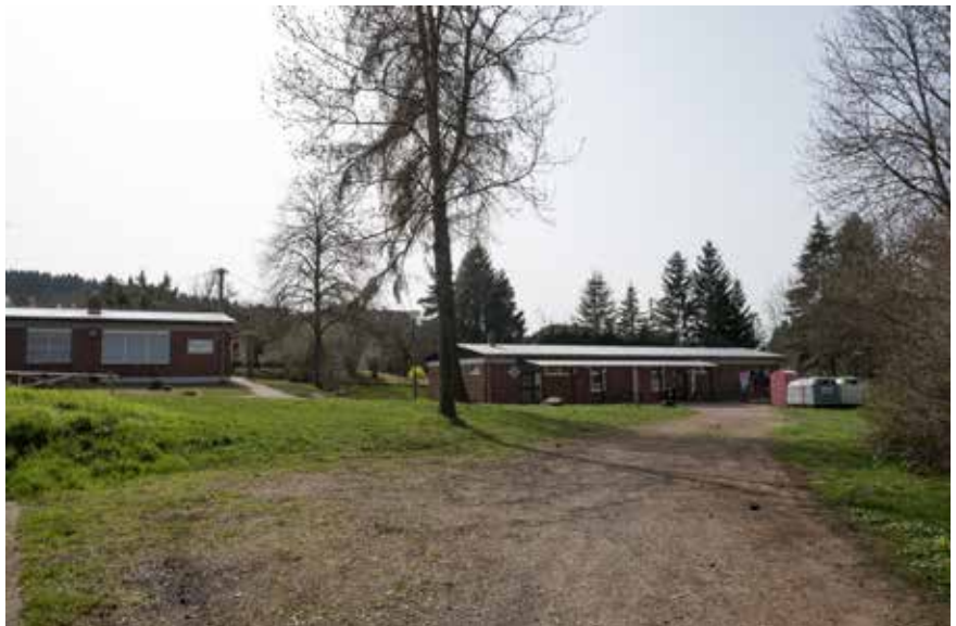
und Feuerwehrgerätehaus mit Sanierungs- und Aufwertungsbedarf
