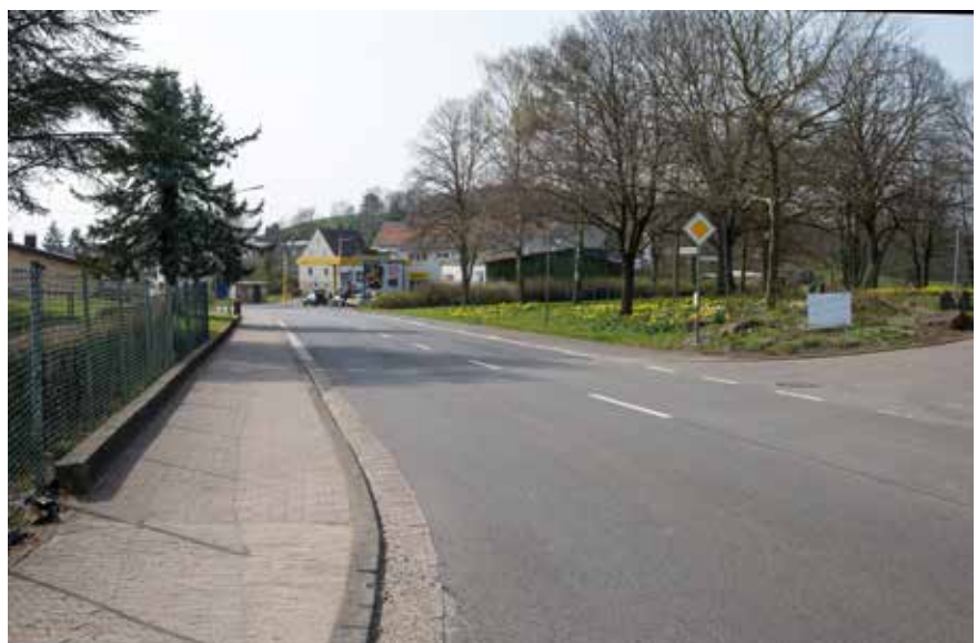
Östlicher Bereich der Ortsdurchfahrt „Welschbachstraße“ (L 141) mit Aufwertungsbedarf
