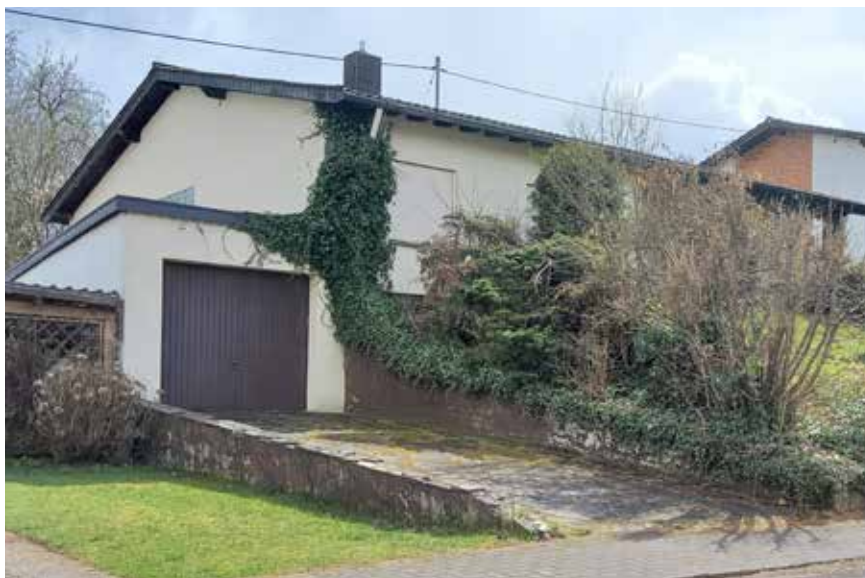
Wohngebäude-Leerstand im Bereich der Ringstraße
