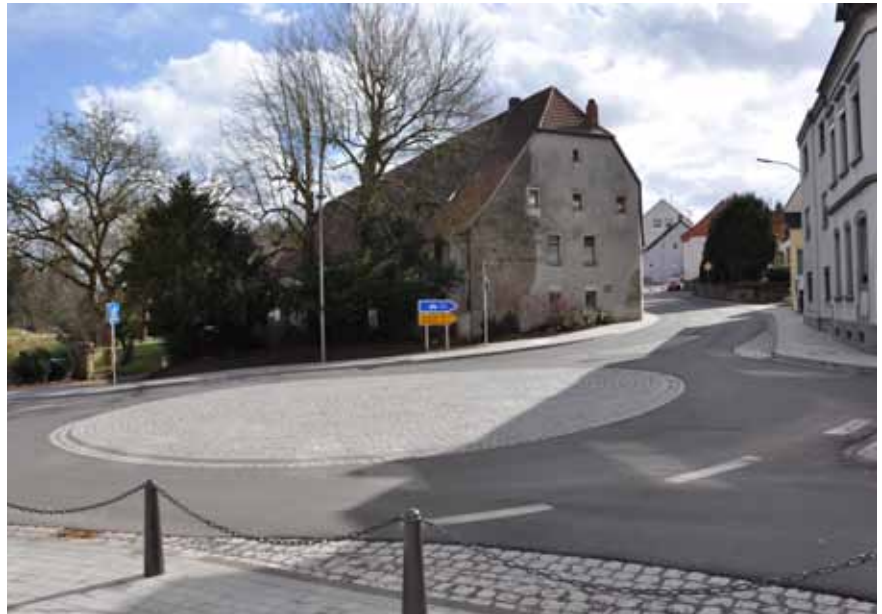
Der neu angelegte Kreisel Hauptstraße / Gennweiler Straße
